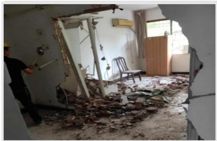
图 7：“格子房”整改过程中，工人正在拆除隔断墙体
