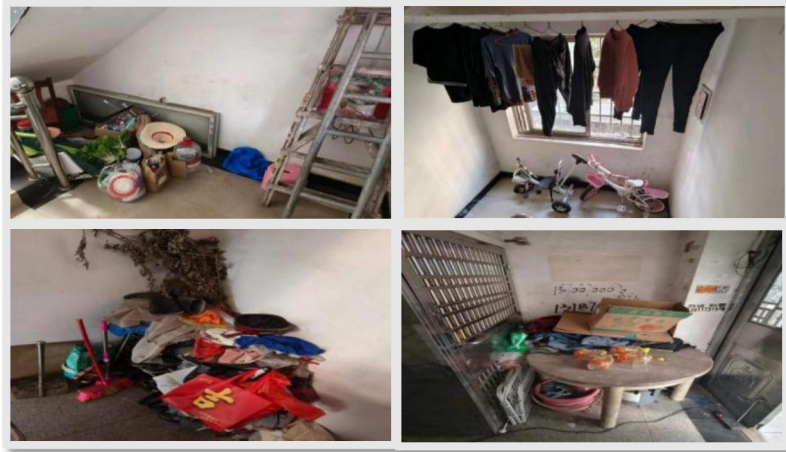
图 4：杂物从各楼道堆到了楼栋入口
