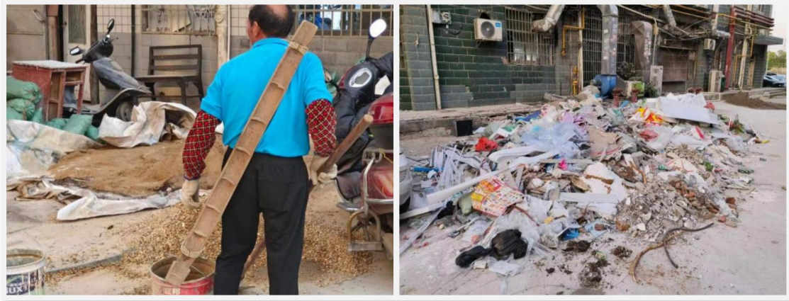
图 26：正在施工的民工及清运出来的建筑垃圾
